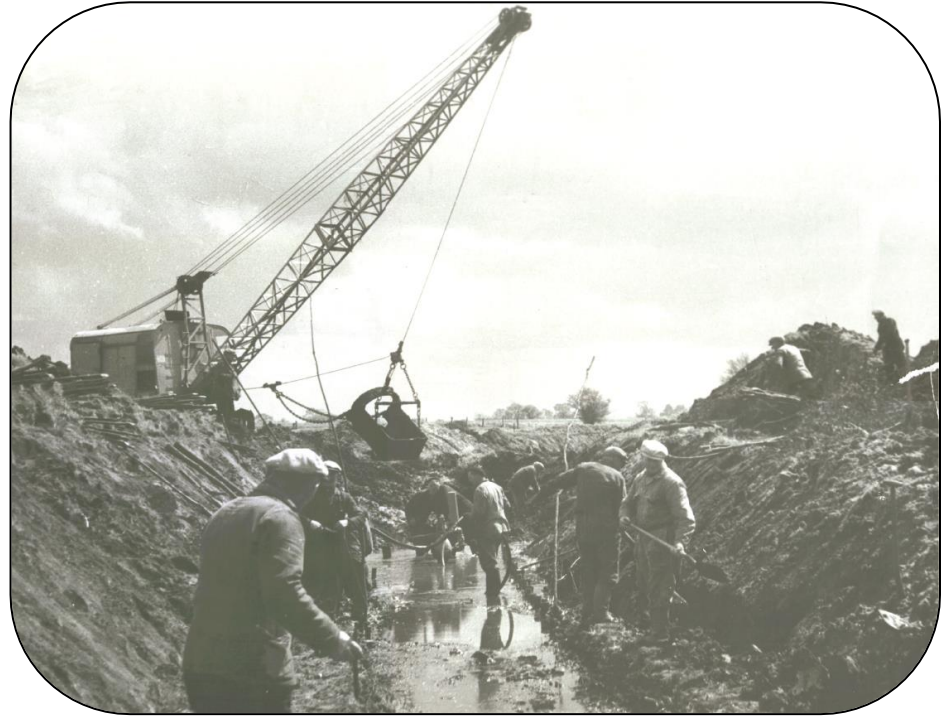
Kanalisatie van de Ruiten Aa (archief ws H&A)
