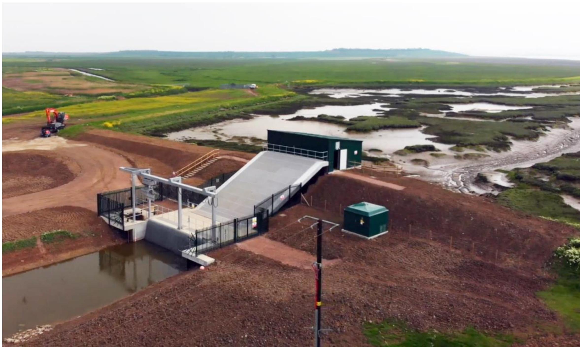
Buisvijzel gemaal Bells and Mocketts
